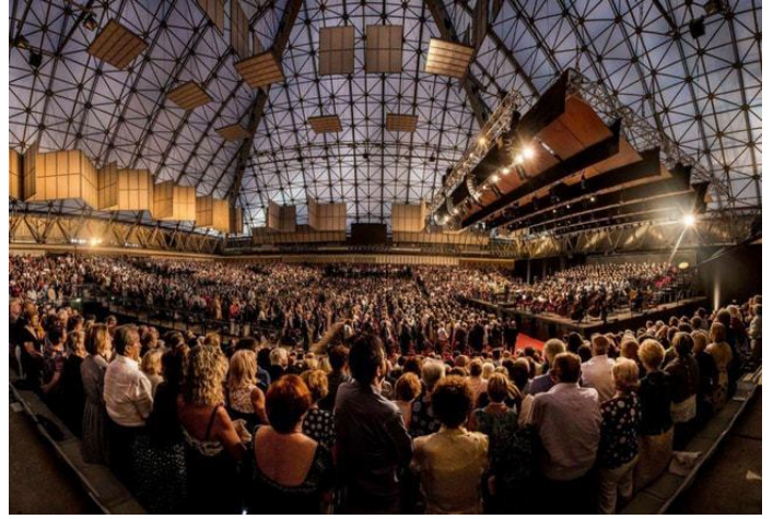
Progetto e realizzazione intervento di correzione acustica per il Palazzo "Mauro De Andrè" - Ravenna
